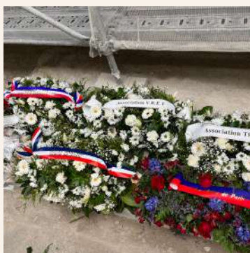
Explosion de gaz rue de Trévis à Paris, 12 janv. 2024
